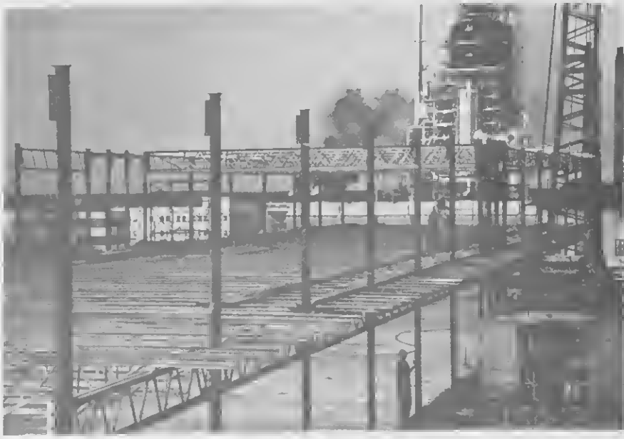
THE SECOND floor begins to take shape as a steel skeleton. E SEGUNDA piso ta cuminza haya forma como un skeleton di staa.
